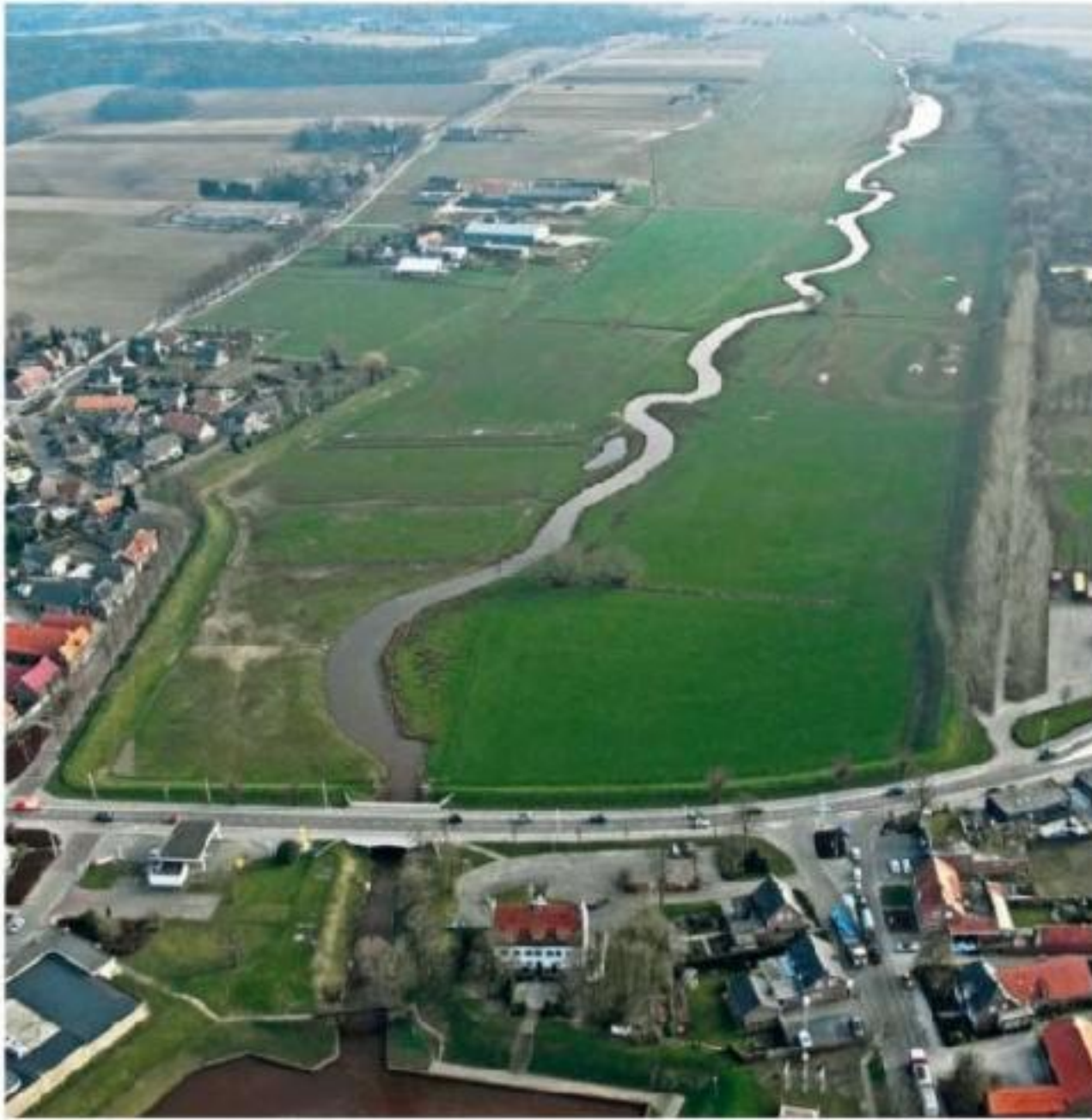
Brug Wanssum laat nu maar over breedte van 6 meter water door. FOTO PROJECTBUREAU OOIJEN-WANSSUM
