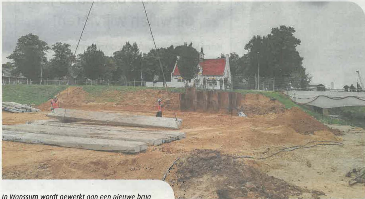
In Wanssum wordt gewerkt aan een nieuwe brug
