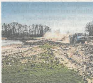
Werkzaamheden in Ooijen-Wanssum. ARCHIEFFOTO STEFAN KOOPMANS
