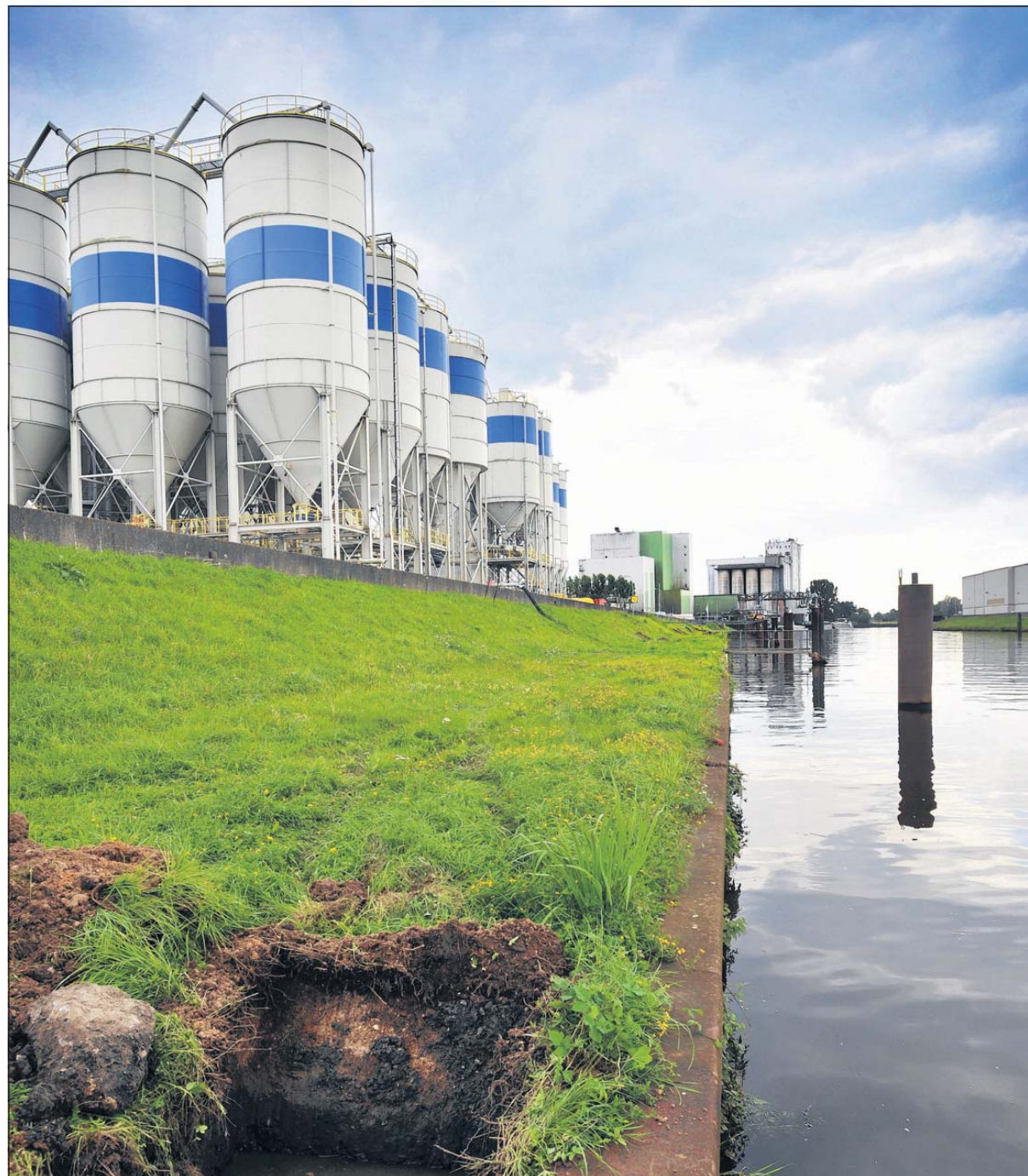
Langs de oostelijke oever van de industriehaven wordt een nieuwe, hoge damwand geslagen.
